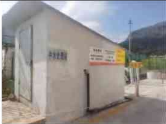
项目依托污水处理站现状
